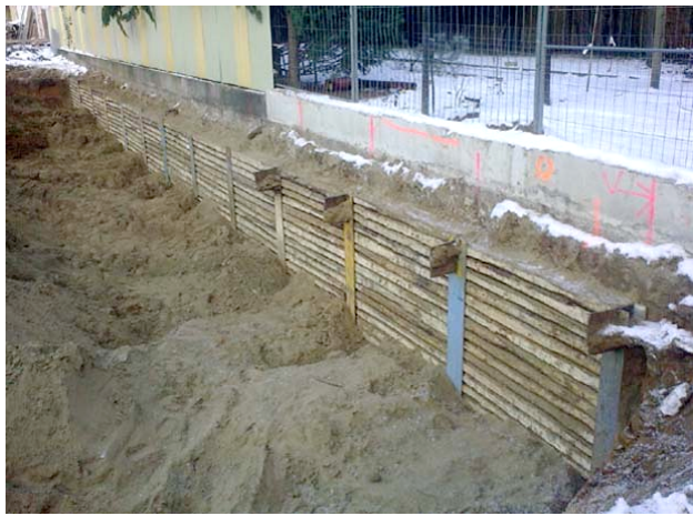
Abb. 3 : Baugrubensicherung dicht an einem bestehenden Mauersockel
