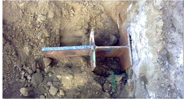
Abb. 2 : Dicht an die Betonmauer gestellter Stahlträger
